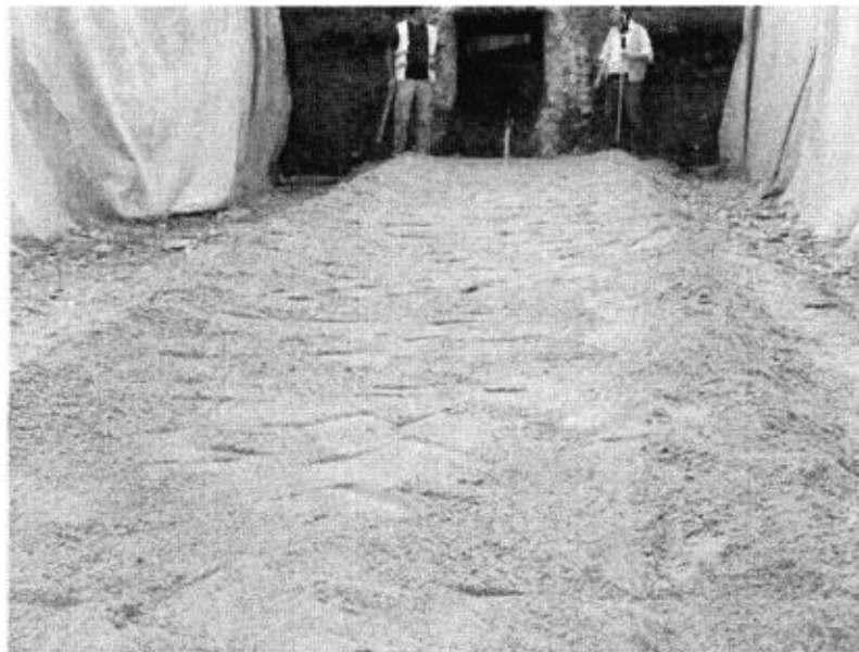
[fig. 4] Modelarea stratului talpa dupa forma structurii metalice
