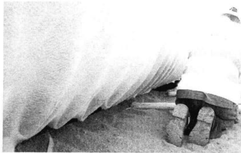
[fig. 15] Compactarea manuala cu maiul.
