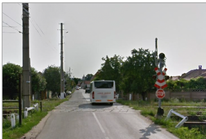
Figura 2.21. Trecere la nivel cu calea ferată (Exemplificare: Str. Călărași).
